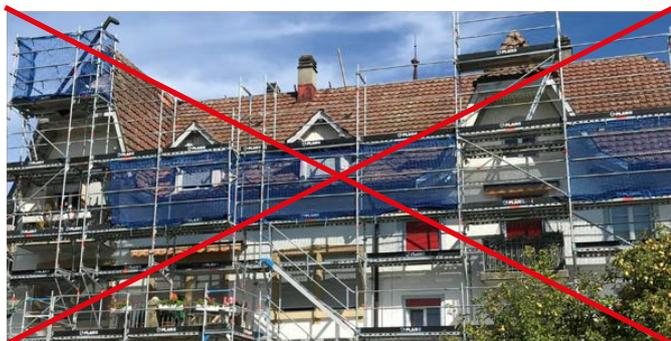
Achtung: Bild ist auf Grund des Art 56 a nicht mehr zugelassen. Die Treppe muss im Traufbereich bis nach oben geführt sein. Durchstiegsbelag ist nur im Giebel erlaubt.
